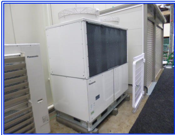
【Outdoor Unit: 15hp Refrigerator】
